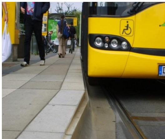
Rys. 9.8.2.1. Zalecane ukształtowanie krawędzi peronowej.
