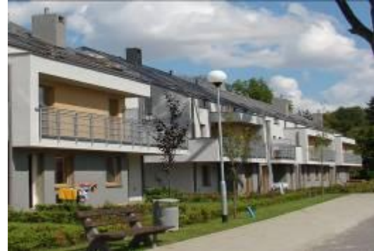
Osiedle Lotnisko ul. J. Śniadeckiego 3 a - b, termin realizacji: 2008-2009 r. 16 mieszkań w tym 1 dla osoby niepełnosprawnej ruchowo.
