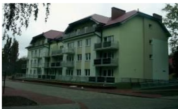
ul. Cz. Tańskiego - termin realizacji 2003-2004r. 48 mieszkań w tym 6 dla osób z dysfunkcją ruchu.
