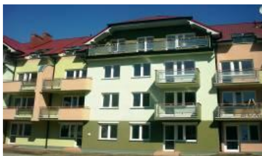
ul. Cz. Tańskiego - termin realizacji 2005-2006 r. 46 mieszkań w tym 3 dla osób z dysfunkcją ruchu.
