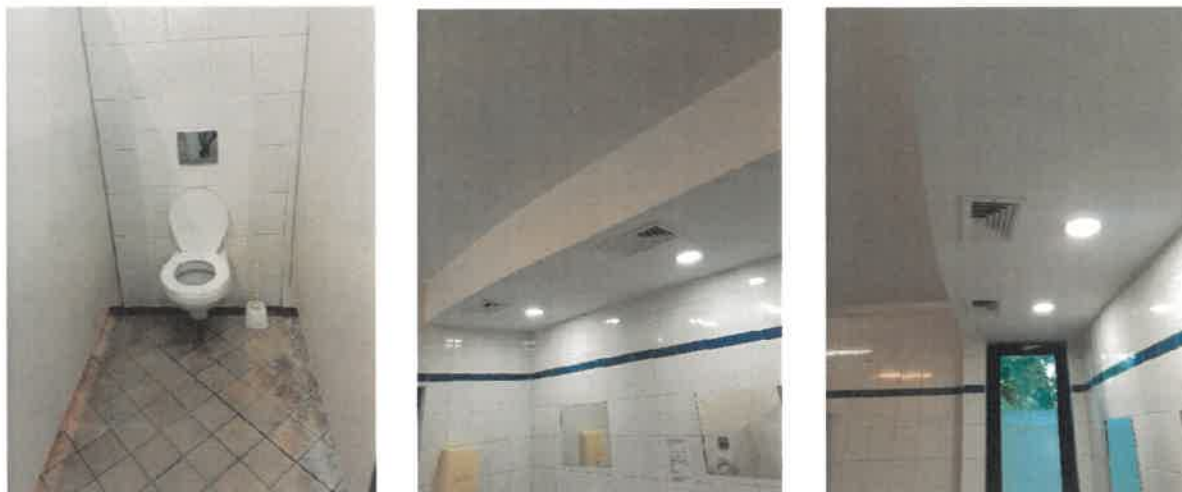
Fotografia 41,42,43. Remont w szalecie – Plac Wolności.
