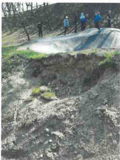
Fotografia 31. Uszkodzona skarpa
