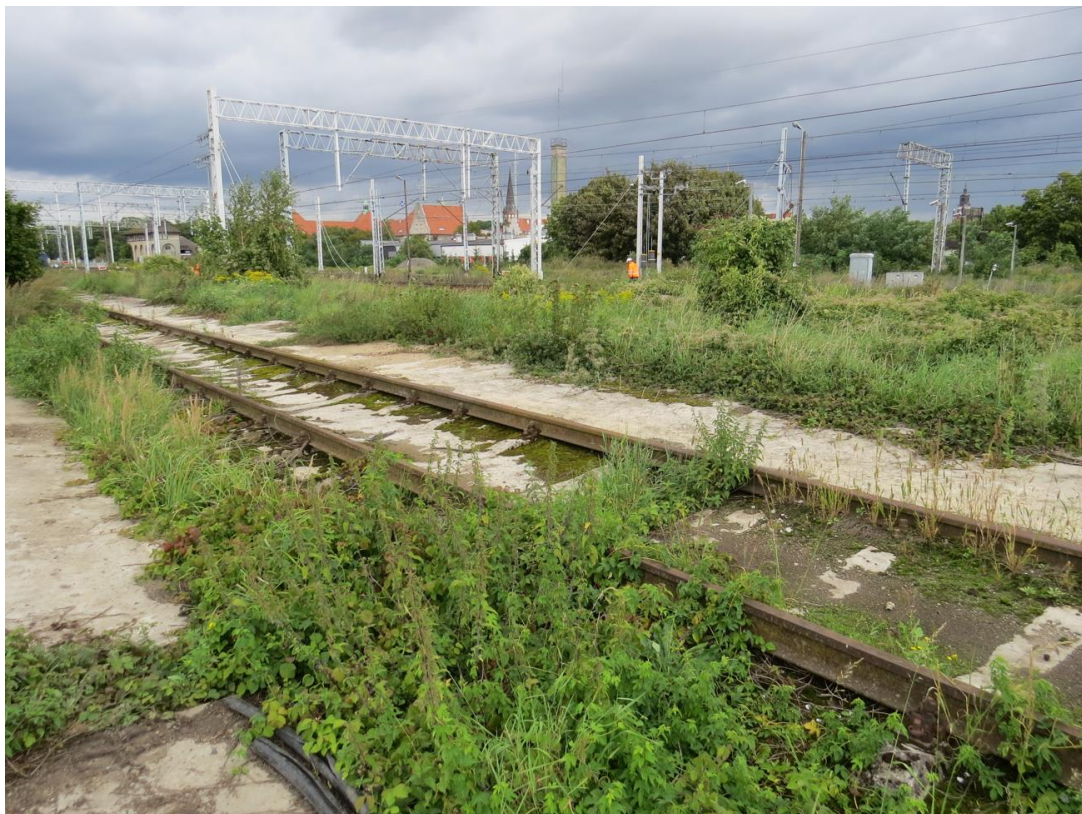
Fot. 13. Nieużytkowane oraz użytkowane tereny torowisk, również objętych projektowanym miejscowym planem zagospodarowania przestrzennego (autor: G. Nordlów 2023 r.).
